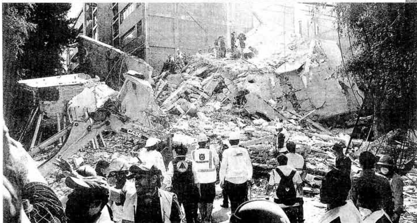
EN LA RUINA. La alcaldía de la Ciudad de México informó que, al menos, 49 edificios colapsaron por el terremoto. Momentos del movimiento telúrico fueron captados por varios usuarios de redes sociales.
